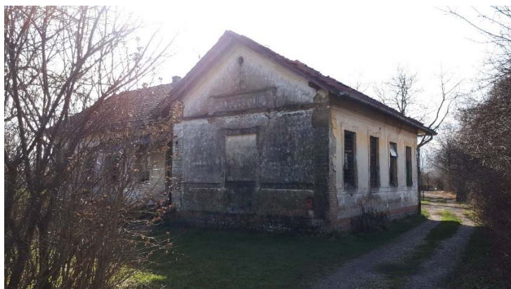
slika 20. Pogled na pučku školu
