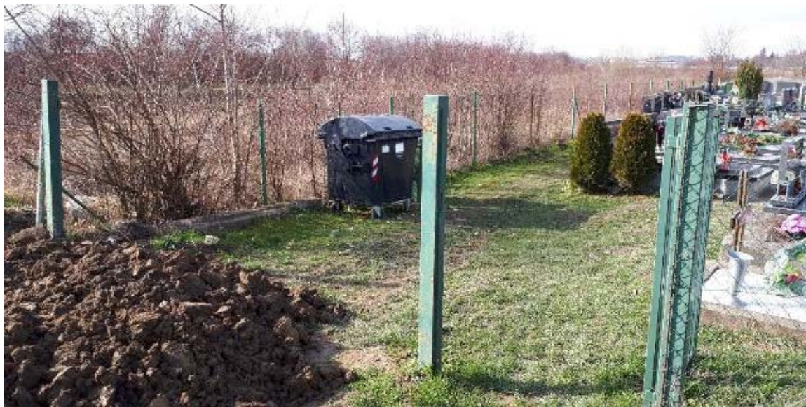
slika 25. Neadekvatno navažanje viška zemlje na postojećem groblju
